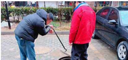
专项供暖失水治理
